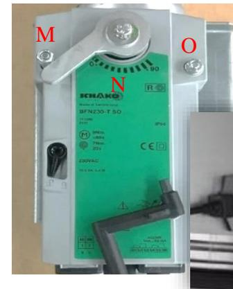
**Funktionsprüfung durchführen. Sicherheitsfunktion des Antriebs ist nur gewährleistet, wenn der Antrieb vorschriftsmäßig an Nennspannung angeschlossen und dieser mechanisch entriegelt ist.**
